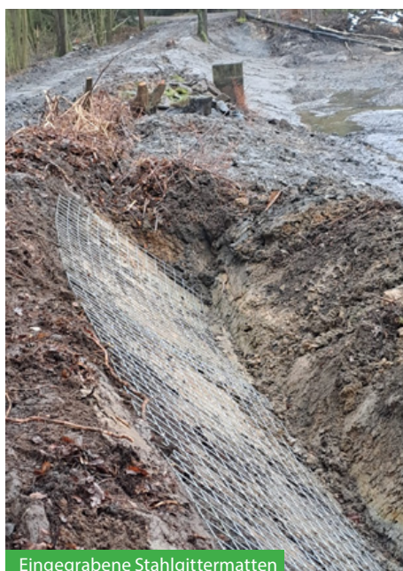
Eingegrabene Stahlgittermatten
