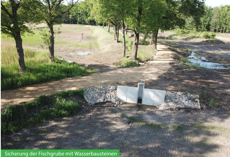
Sicherung der Fischgrube mit Wasserbausteinen
